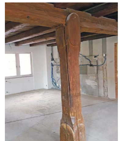
Der erhaltenswerte Stud im 2. Obergeschoss.
