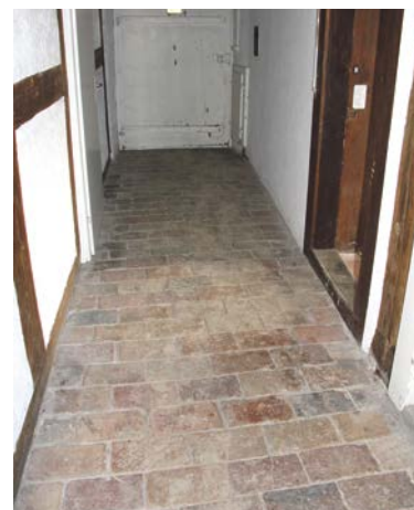
Alte Tonziegel aus der ehemaligen Klosterziegelei.
