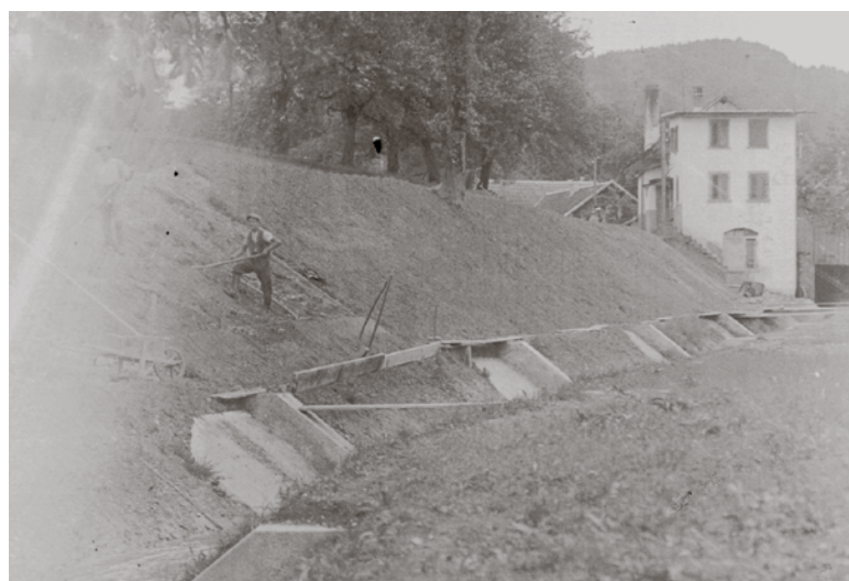
Verbauungen wegen Erosion, hinten Stämpfi.
