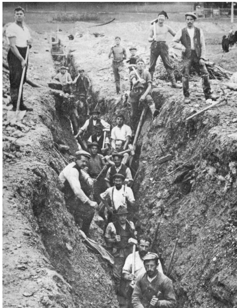
Meliorationsarbeiten im Seefeld.
