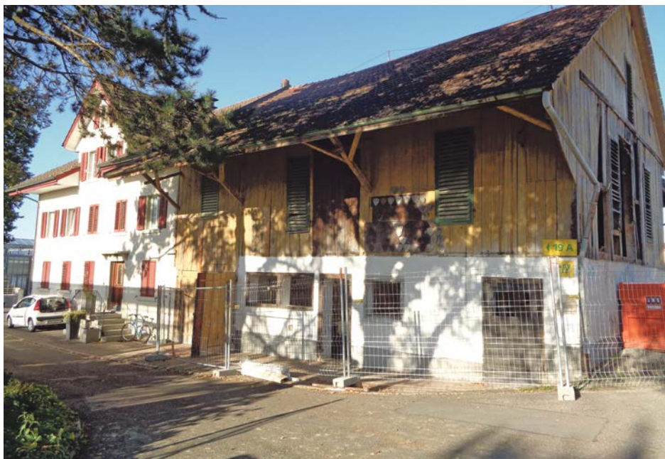
Kurz vor Abbruch des Scheunenteils.
