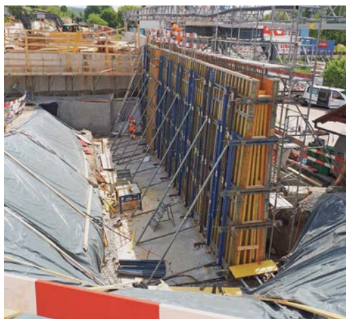
Grosser Verbrauch an Beton: links Stützmauer, Mitte Aufgang zum Perron, rechts Unterführung für Fussgänger und Velofahrer.
