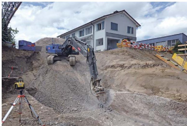
Das Stationsgebäude nach dem Abbruch der Eisenbahnbrücke.
