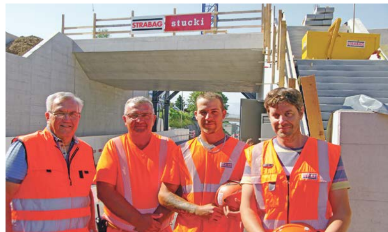
Die verantwortliche Bauführung: von links Hanspeter Jacober (Technische Leitung), Francesco Amore (Polier), Marco Mason (Polier) und Albin Zimmermann (Baustellenchef).
