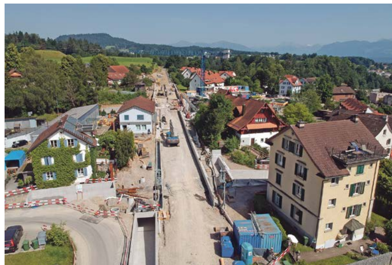
Hier entsteht die zweigleisige Bahnlinie in Richtung Wald.
