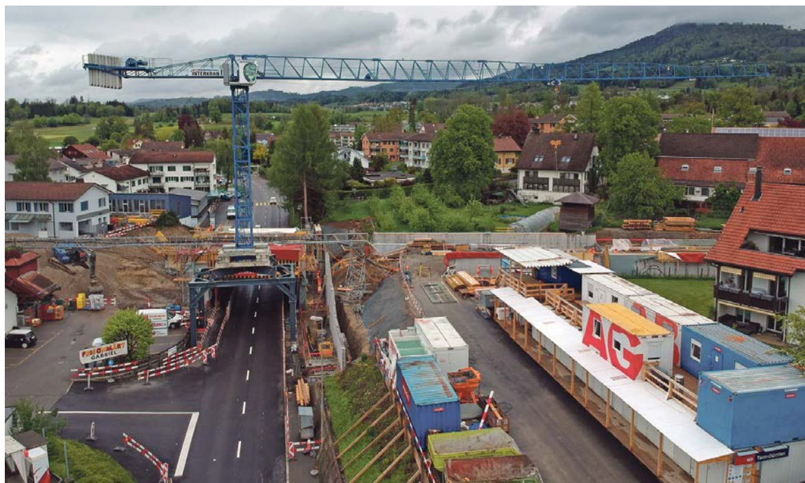
Grossbaustelle Bahnhof Tann aus der Vogelperspektive.
