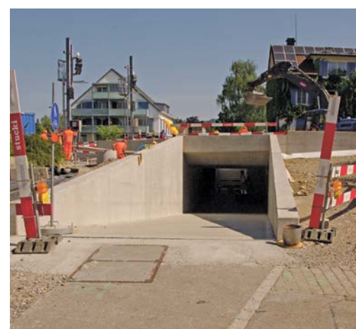
Grosser Verbrauch an Beton: links Stützmauer, Mitte Aufgang zum Perron, rechts Unterführung für Fussgänger und Velofahrer.
