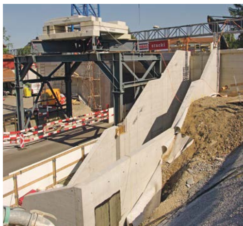
Grosser Verbrauch an Beton: links Stützmauer, Mitte Aufgang zum Perron, rechts Unterführung für Fussgänger und Velofahrer.
