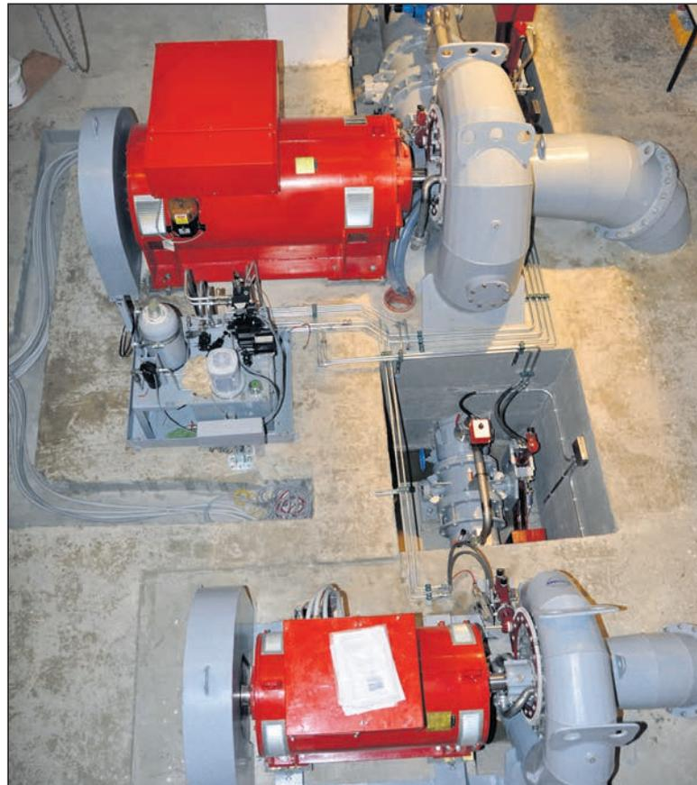
Die beiden neuen Kössler-Turbinen mit Leistungen von 1500 l/sec und 300 l/sec.
