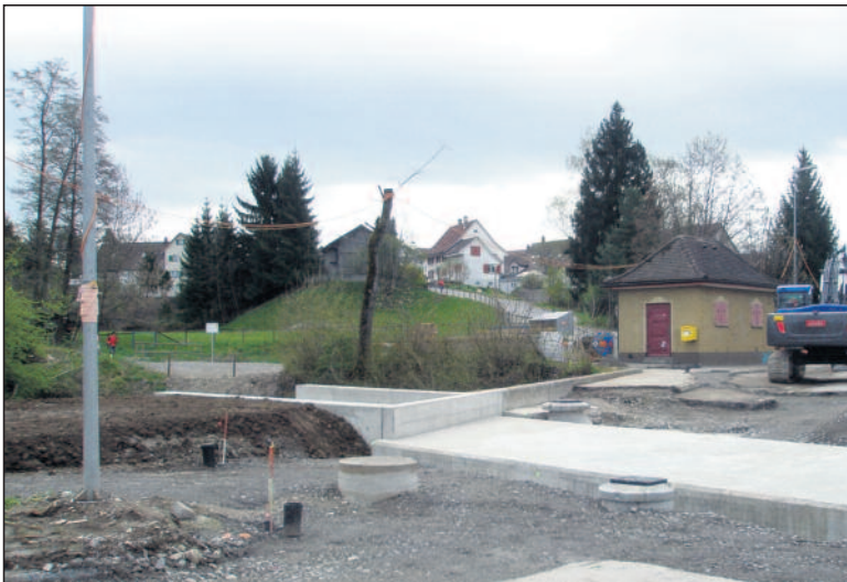
Der Durchlass des Nauenbachs ist fertiggestellt und überteert. Die beiden Fahrstreifen sind wieder offen. In der Mitte ist die lange und breite Mittelsinsel markiert. Alles ist noch provisorisch festgelegt und wird erst nächstes Jahr fertiggestellt.
