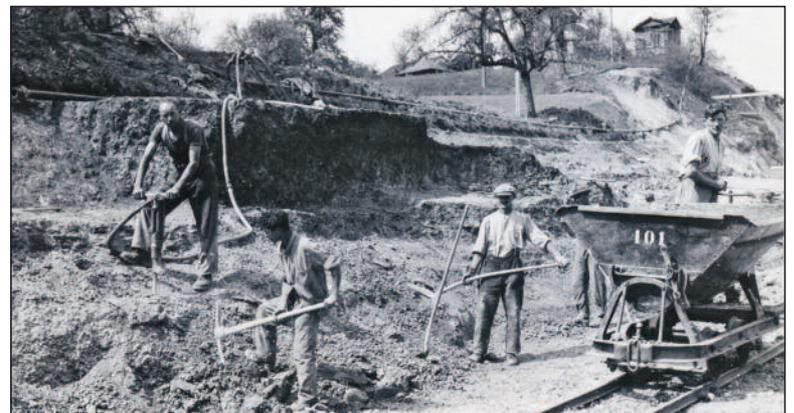
Im obersten Teil wurde der Edikerstich 1937 tiefer gelegt und nach Westen verschoben, der ganze Strassenzug begradigt. Mit einem Pressluft-Meissel bohrte man die Sprenglöcher. Das schwere abgebaute Material wurde mit Transportwagen auf Rampen gestossen und auf Wagen oder Lastwagen gekippt.
