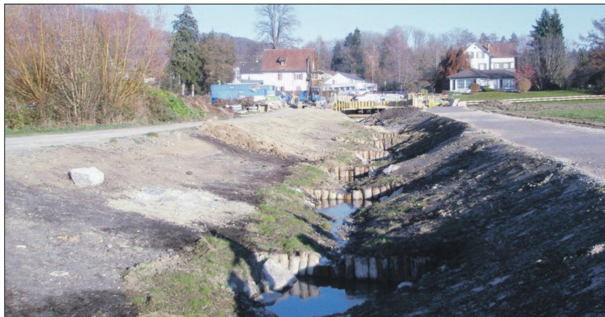
Das Bett des offen gelegten Bachs wird mit Rundhölzern und Steinen gesichert. Das Gefälle wird durch querliegende Schwellen aus Pfahlreihen gebrochen. Auf der linken Seite ist der Possengrabenweg, rechts die Fortsetzung des Schachenrietwegs und die im Bau befindliche Brücke (17. 11. 2011).
