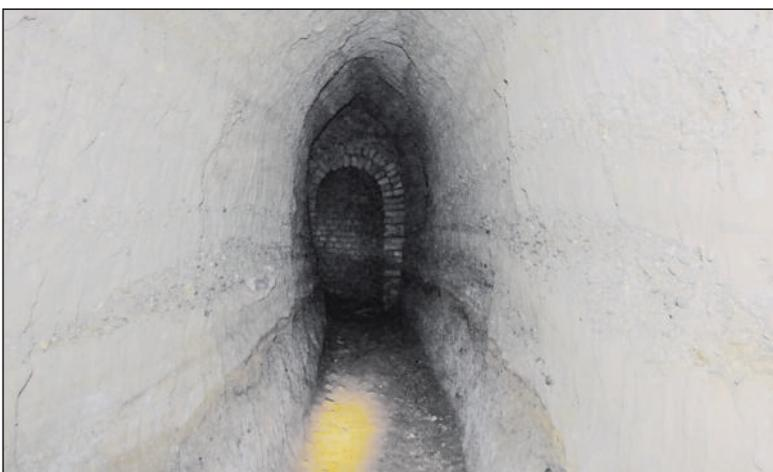
In die fest gepressten eiszeitlichen Ablagerungen (Sand mit Kies-schichten) wurde 1867 der Stollen weiter in den Hang hinein gegraben und mit einer Abzweigung versehen. Hinten im Bild sieht man den Anfang des kurzen Gewölbestückes der ÜBB. (Foto: Roman Schmid)
