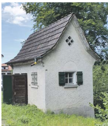
Gasventilatoren beim Pilgersteg.
