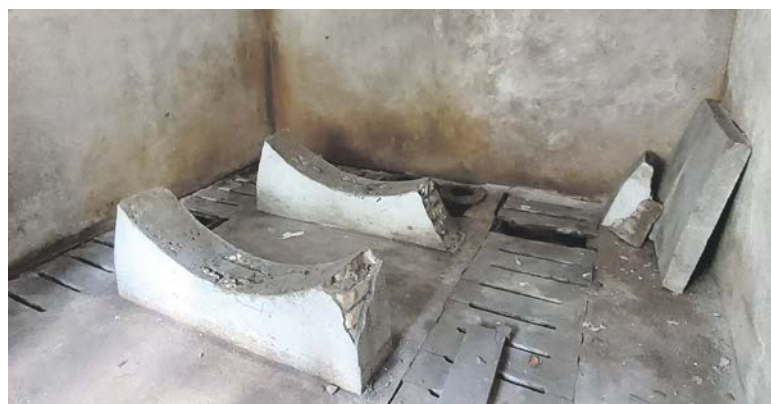
Sockel des ehemaligen Messkessels.
