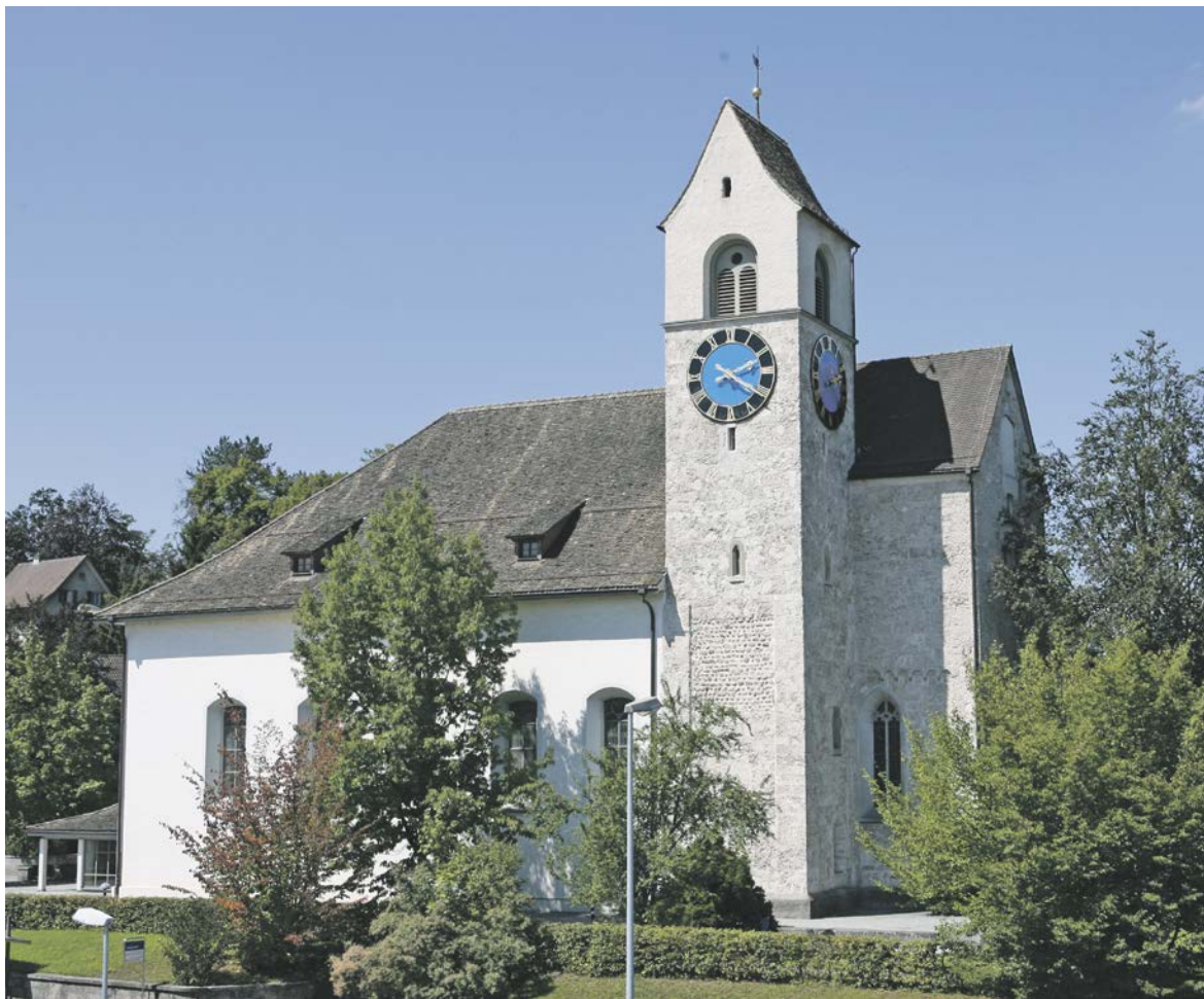
Renovierter Kirchturm ohne weisse Mörtelschicht.
