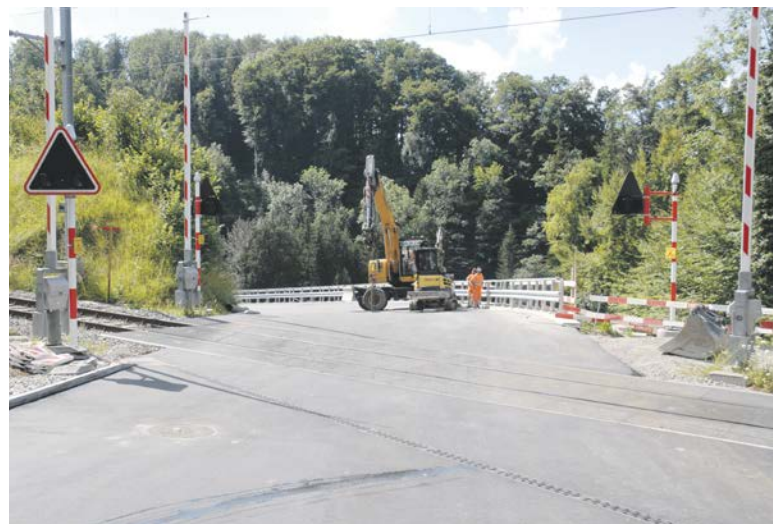
Beim Bahnübergang arbeiteten im Juli noch Bagger.
