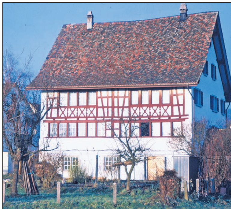
Riegelhaus, Dürnten, von Süden, 1983, nach der Renovation.
