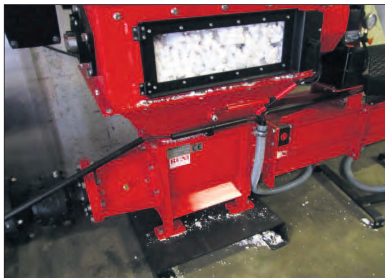
Geschreddertes Styropor im Sichtfenster der Anlage.
