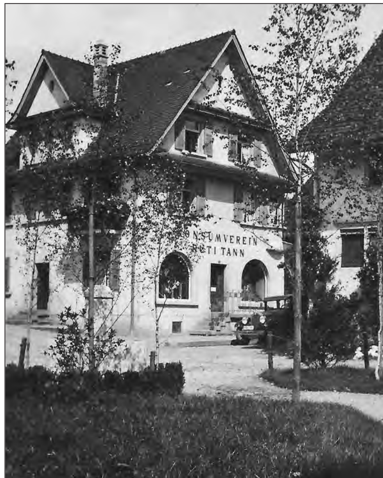
Zugang ins einstige Pärkli an der Fägswilerstrasse. (Bild ca. 1935)
