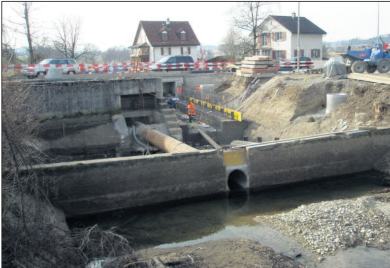
Der Kiessammler musste zur Hälfte trockengelegt und das Wasser des Nauenbachs in die alte Röhre geleitet werden, bis der Durchlass und sein in den Weiher ragender Einlauf betoniert waren.
