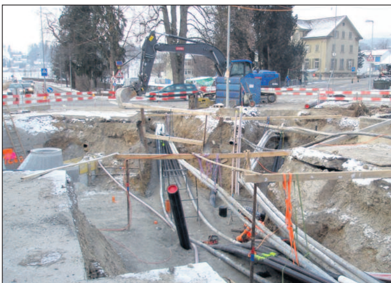
In der Baugrube sind die vielen Röhren und Leitungen sichtbar: für Wasserversorgung, Kanalisation, Elektrizität und Gas, Strassenbeleuchtung, Telefon- und Fernsehempfang. Die Umfahrung der grossen Baustelle verlangte von den Chauffeuren einiges Geschick.
