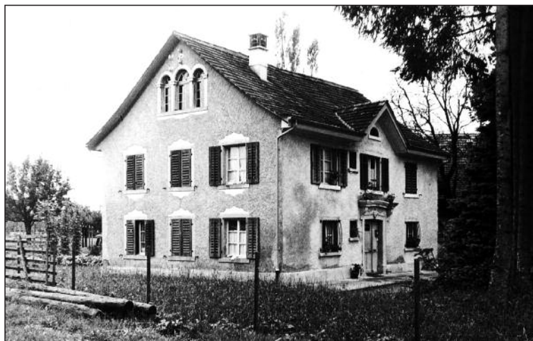
An der Bubikonerstrasse (heute Nr. 19), ausserhalb des damaligen Dorfes, baute 1834 eine Privatperson ein Wohnhaus. Dieses kaufte sechs Jahre später der Aktienverein des Sekundarschulkreises Dürnten. Während über 20 Jahren diente es vier Gemeinden als Sekundarschulhaus.
