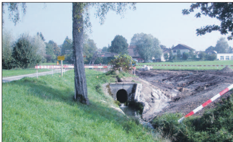
Hier floss seit 1920 das Wasser des Nauenbachs aus der Röhre in den Possengraben. Das neue Bachbett ist im Bau (29. 9. 2011).
