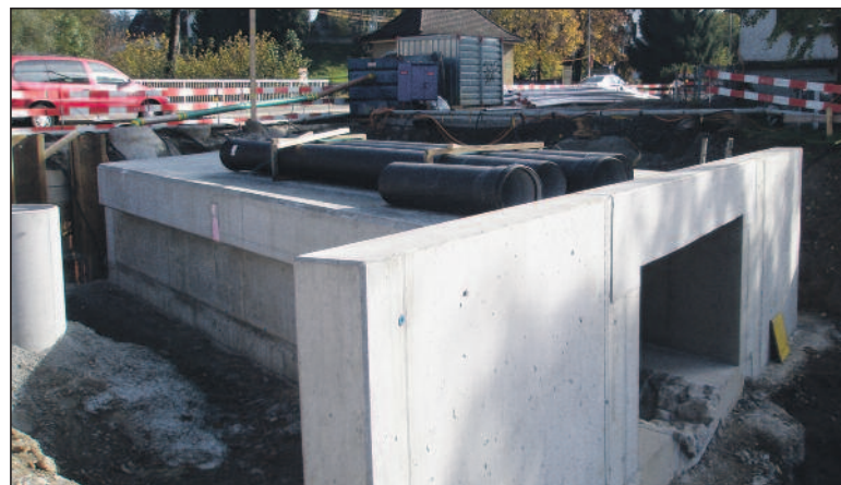
Der bis jetzt gebaute Teil des Durchlasses. Man erkennt die darin mit Blocksteinen ausgelegte Rinne, durch die nach der Fertigstellung das Wasser ins offene Bachbett fliesst (29. 10. 2011).
