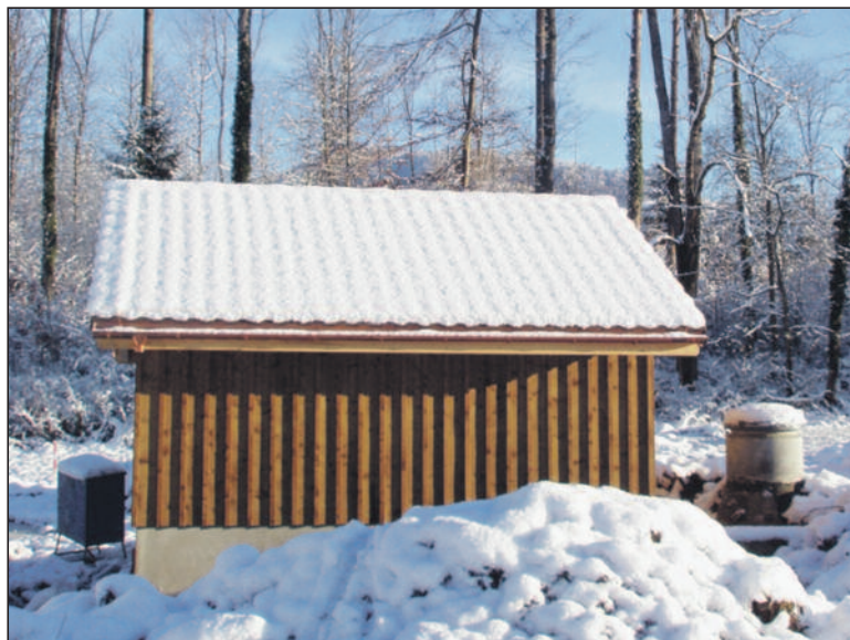
Anstelle des alten, kleinen Pumpenhauses neben der Wasserfassung der Brunnenbühl-Quelle der Zivilgemeinde Tann ist vor kurzem ein grösseres für beide Quellen gebaut worden.
