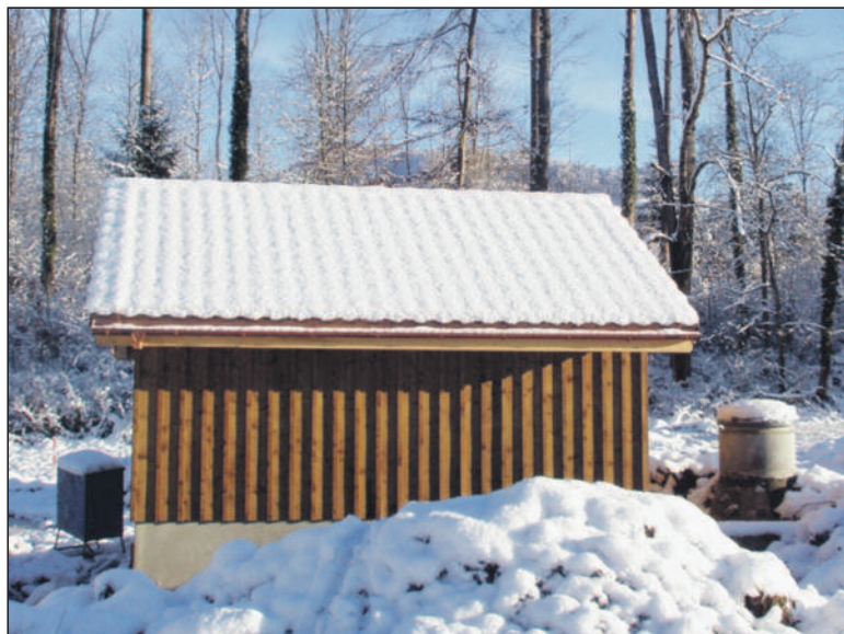
Anstelle des alten, kleinen Pumpenhauses neben der Wasserfassung der Brunnenbühl-Quelle der Zivilgemeinde Tann ist vor kurzem ein grösseres für beide Quellen gebaut worden.
