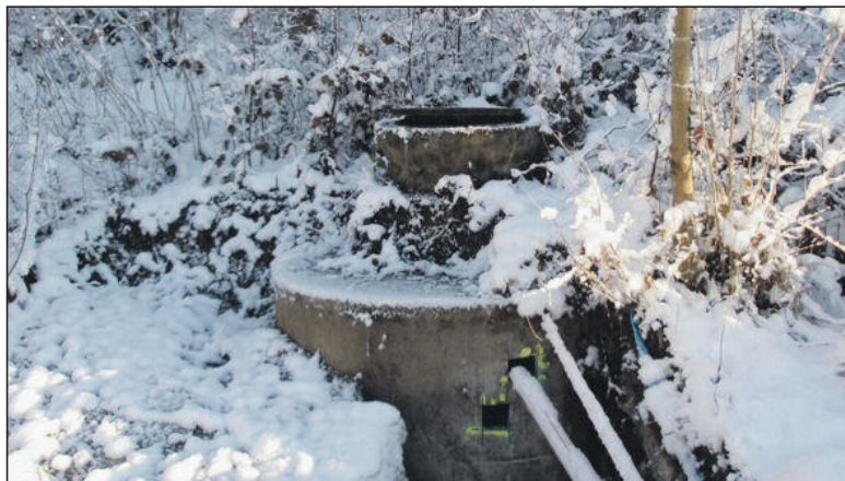
Am Rande des Herrenholzes liegt im Moment die Brunnenstube der neu von der Gemeinde Dürnten gekauften Herrenholz-Quelle frei.
