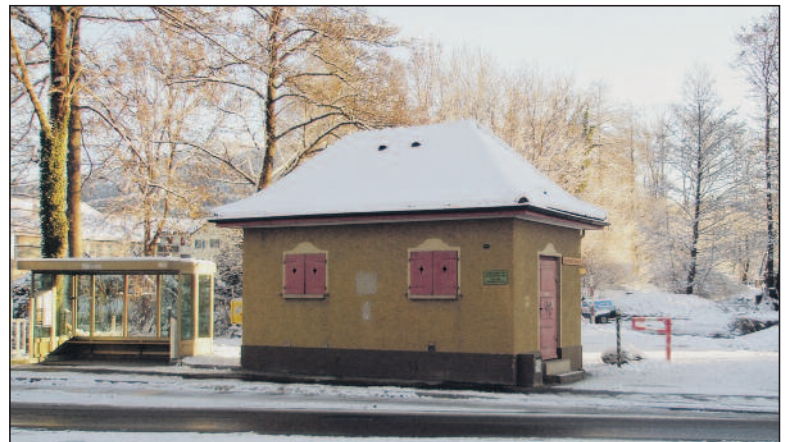
Das Häuschen bei der Bushaltestelle Nauen gehört weiterhin den Gemeindewerken Rütli. Rechts daneben, neben dem Fussweg, soll ein Feuchtbiotop entstehen.
