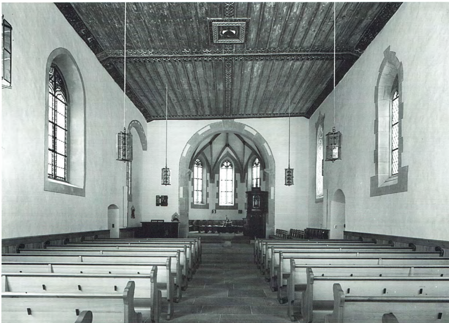
Innenansicht der Kirche Dürnten. Das Schiff ist mit einer flachen Holzdecke, der Chor mit einem Netzgewölbe überspannt.
